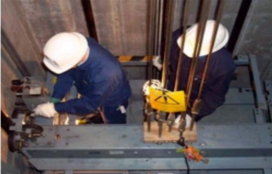
Şekil 2.6: Ray-kabin bağlantısı
