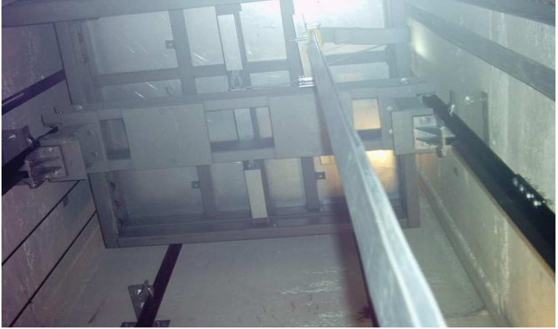
Şekil 2.7: Kabin alt kısmı patenleri
